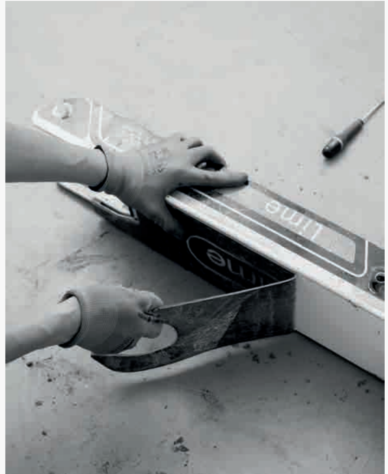
Image 3. Opération de démontage du cadre principal.
